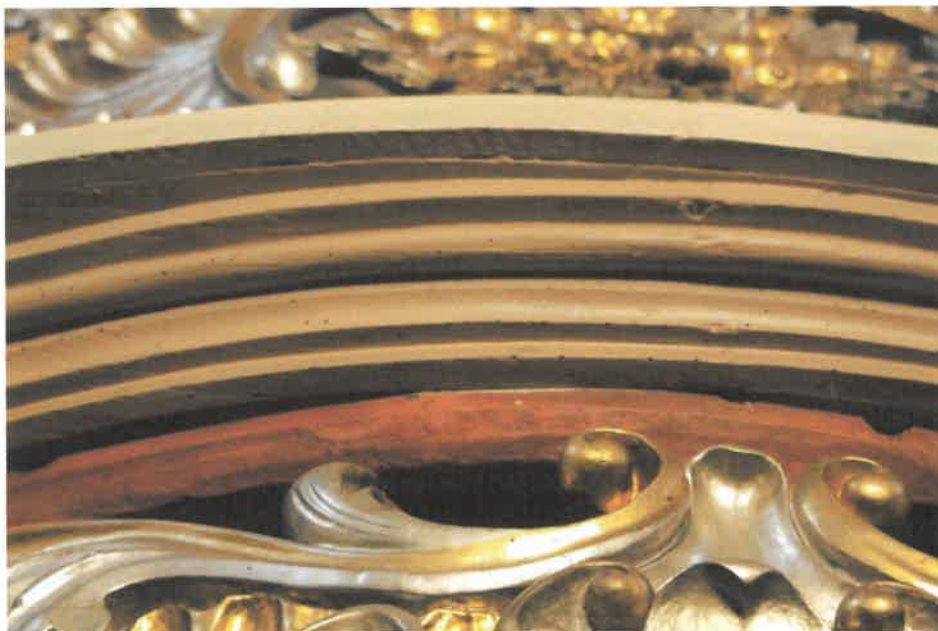
Fragment dekoracji balustrady- widoczne są otwory wylotowe po owadach i drobne uszkodzenia drewna w partii profilowanych listew.
